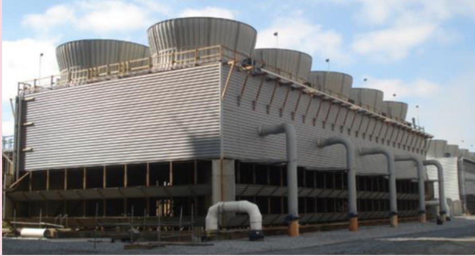
Şekil-10.3 Fabrika montajlı (FAP) soğutma kulesi (içten çekişli çapraz akışlı soğutma kulesi)
