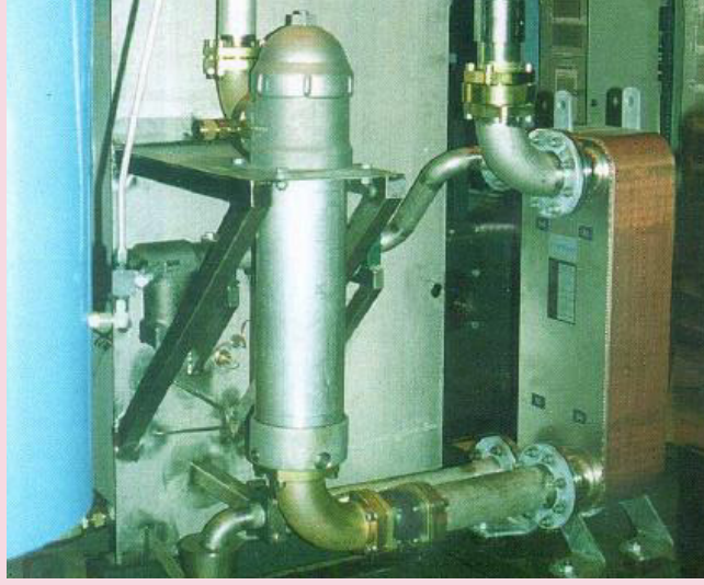
Şekil-4.9 Yağ soğutucusu olarak kullanılan lehimli plakalı deđiřtirici
