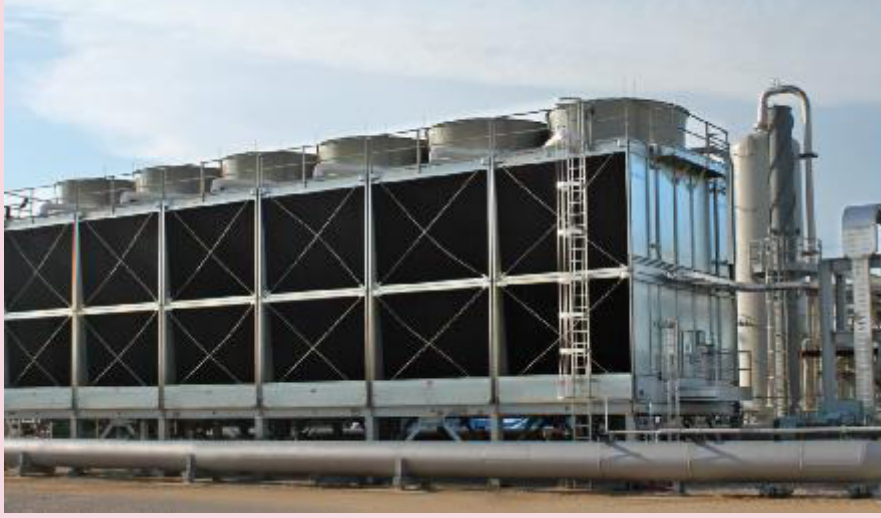
Şekil-10.2 Fabrika montajlı (FAP) soğutma kulesi (içten-çekişli çapraz akışlı soğutma kulesi)
