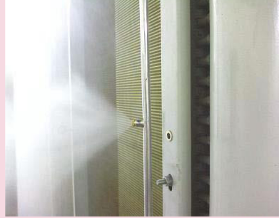
Şekil-10.53 Doğrudan su spreylemeli ıslak-kuru soğutucu Şekil-10.54 Sisleme sistemli ıslak-kuru soğutucu [11]
